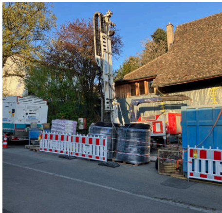
9. April: Bohrarbeiten für Erdsonde
