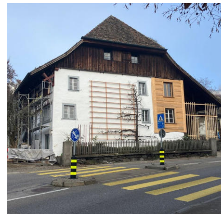
18. Dezember: Die Renovationsarbeiten befinden sich in der Schlussphase
