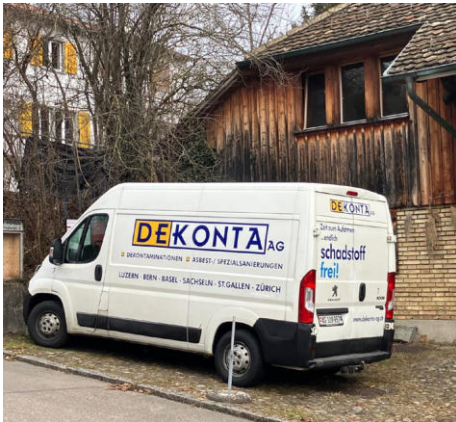
21. Januar: Die Renovation beginnt mit Dekontaminierungsarbeiten
